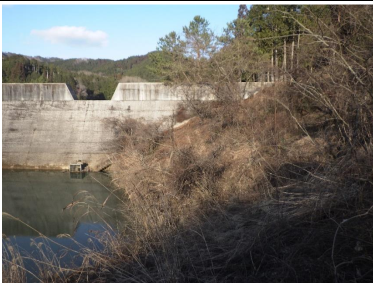
写真-9 対象事業実施区域 B 区の調整池（C）
