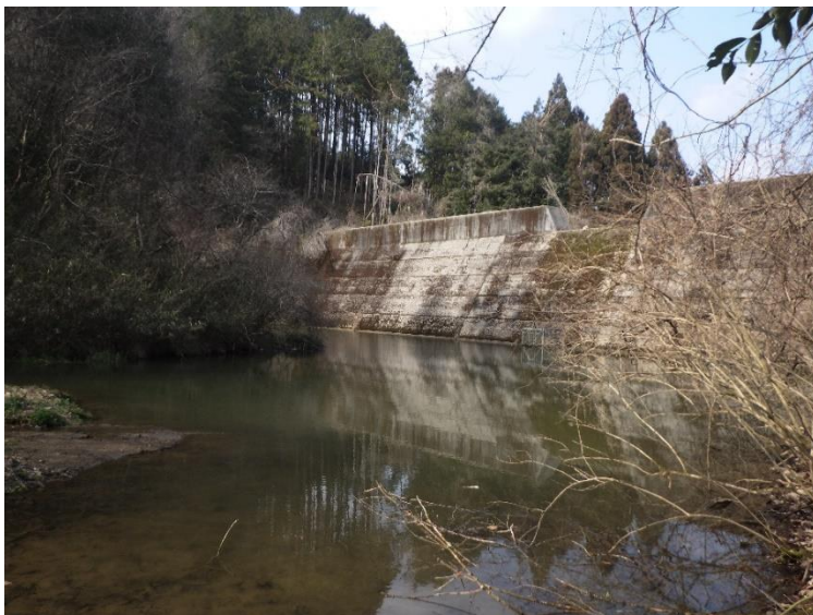
写真-8 対象事業実施区域 B 区の調整池（D）
