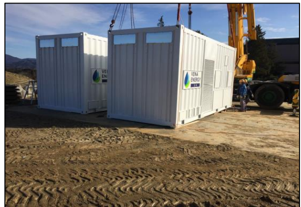
パワーコンディショナー・昇圧 変圧器イメージ
